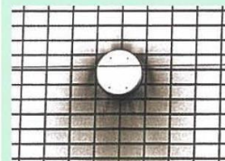
涙漏れによる外壁の変色
